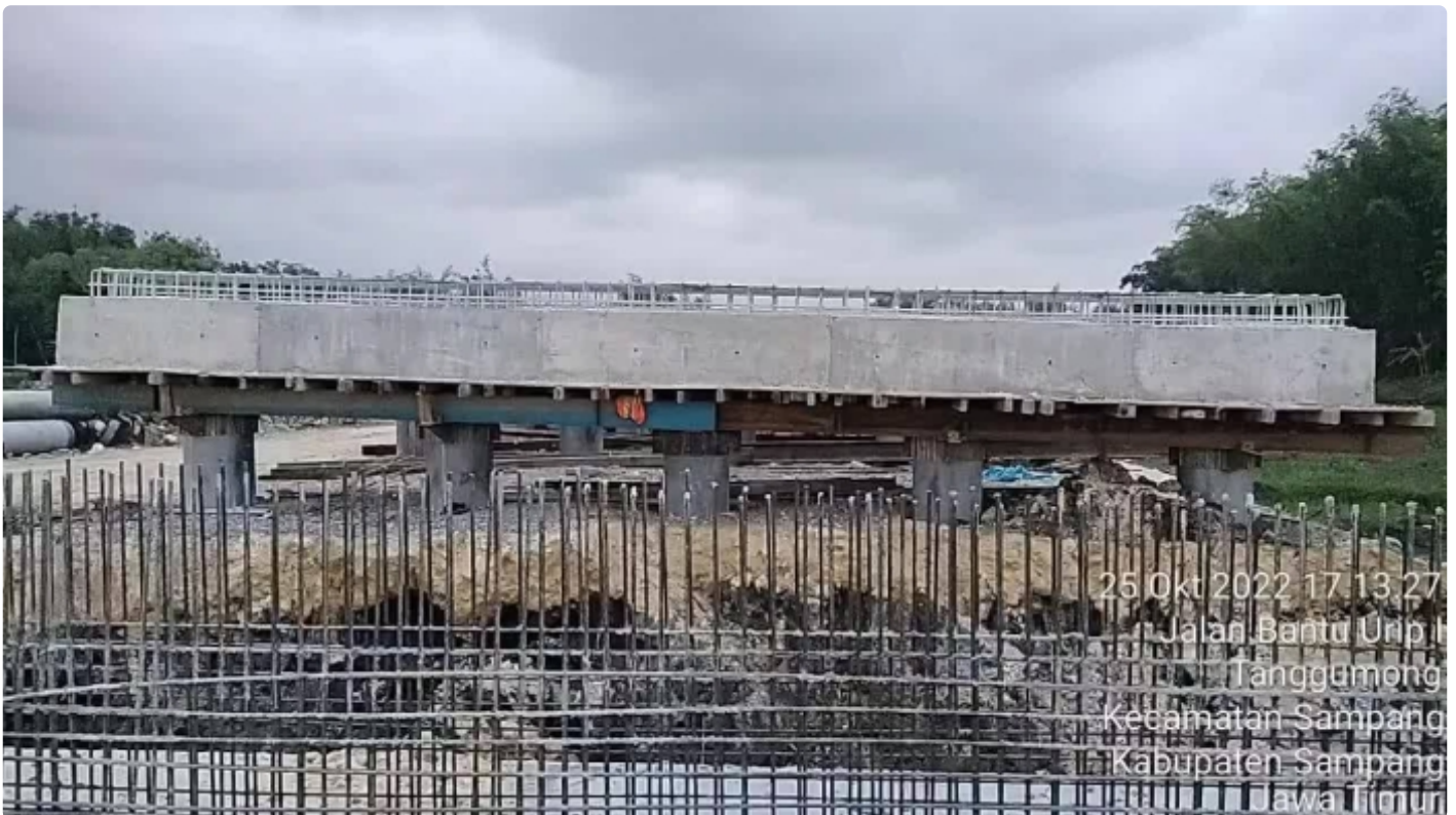
Lokasi Pembangunan JLS Sampang yang masih dikerjakan
